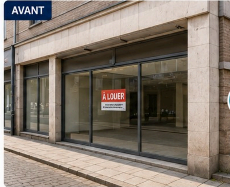
Rez-de-chaussée commercial vacant
